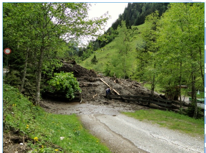
Der Parkplatz „Fleckweide“ und die Straße bei der „Klausen“ wurden verschüttet.
