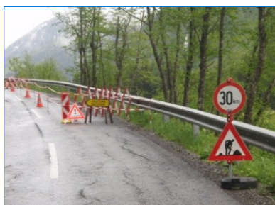
Straßensperre L112 zwischen Marasn und Kathrin's Laden.
